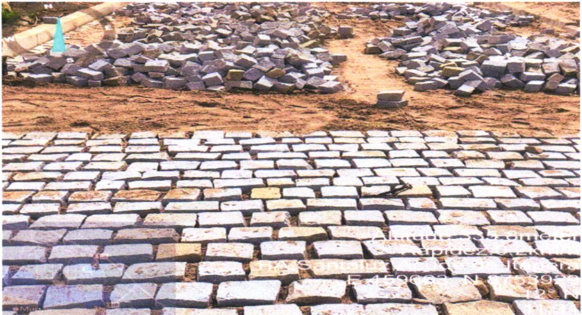
Execução de pavimentação Rua 05
